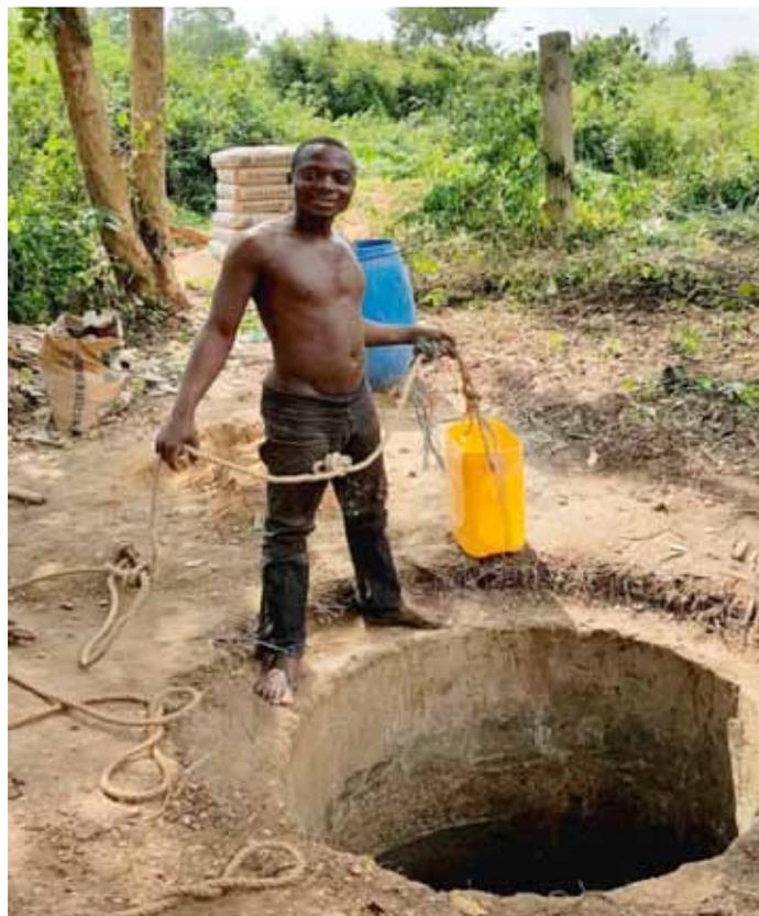
Photo ci-dessus : creusement du puits
